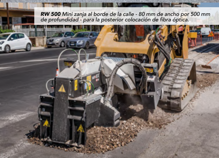
RW 500 Excavación con rueda de 120 mm de ancho para la posterior colocación de fibra óptica.
