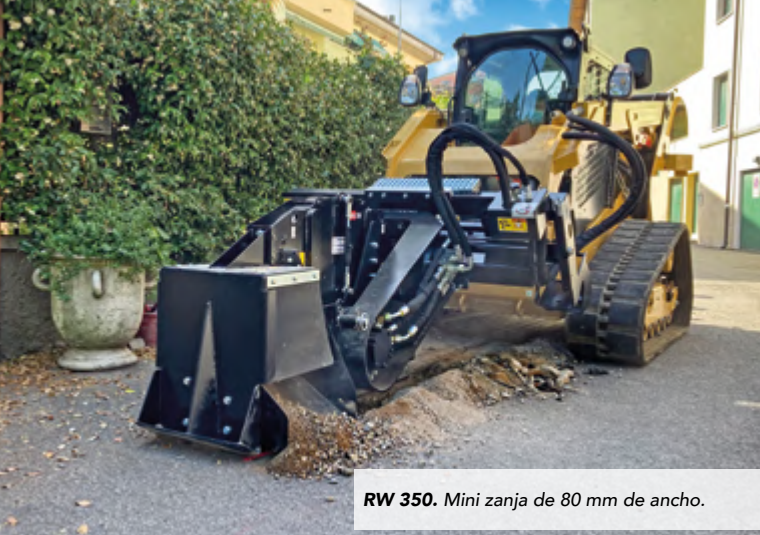
RW 500 Mini zanja al borde de la calle - 80 mm de ancho por 500 mm de profundidad - para la posterior colocación de fibra óptica.
