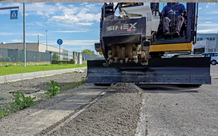
PHD 450 Detalle de canal fresado.
